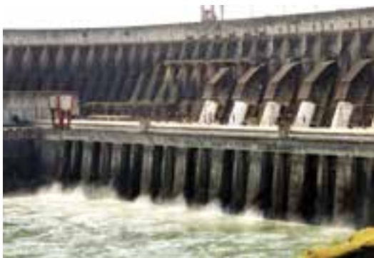
Barragem de usina hidrelétrica.
